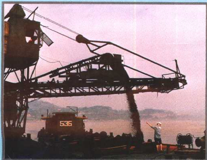
▼ 九龙煤运码头
