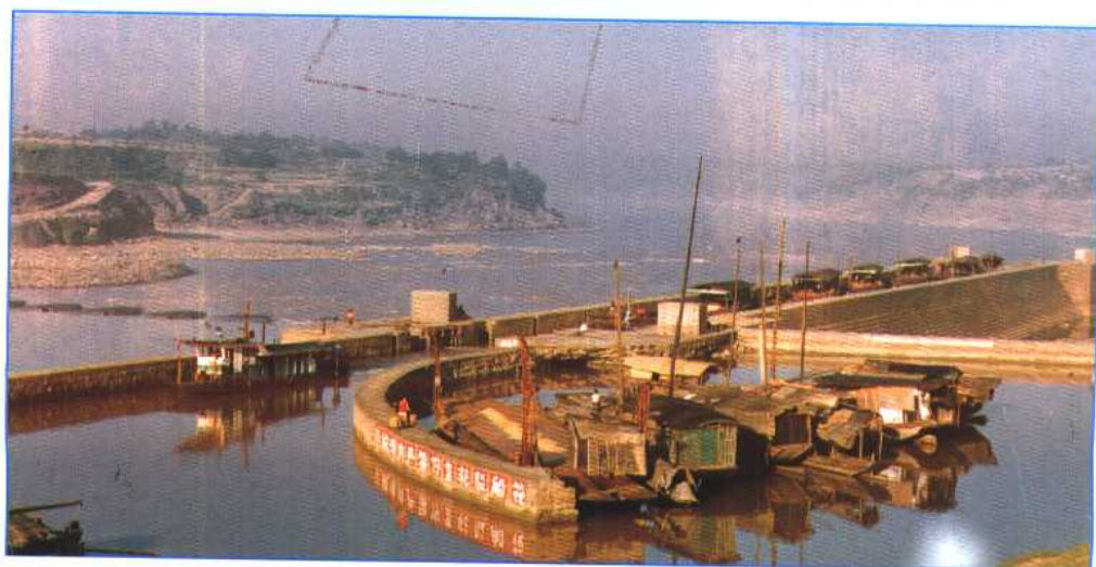
► 渠江为川东北的水运重要干线, 1958 年起, 先后动工修建了三座大型过船闸坝, 渠化航道 94 公里。图为凉滩闸坝
