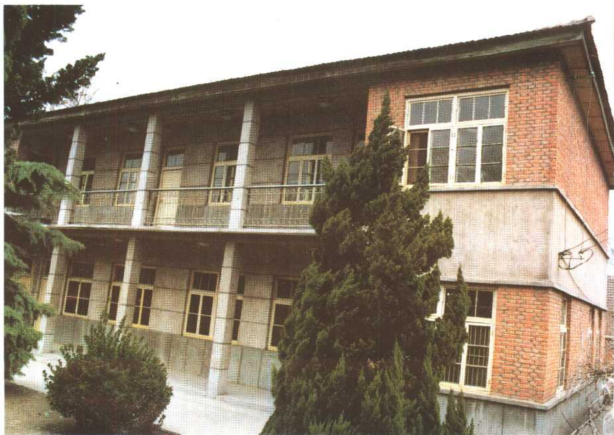
中共萧县 县委办公楼一角
