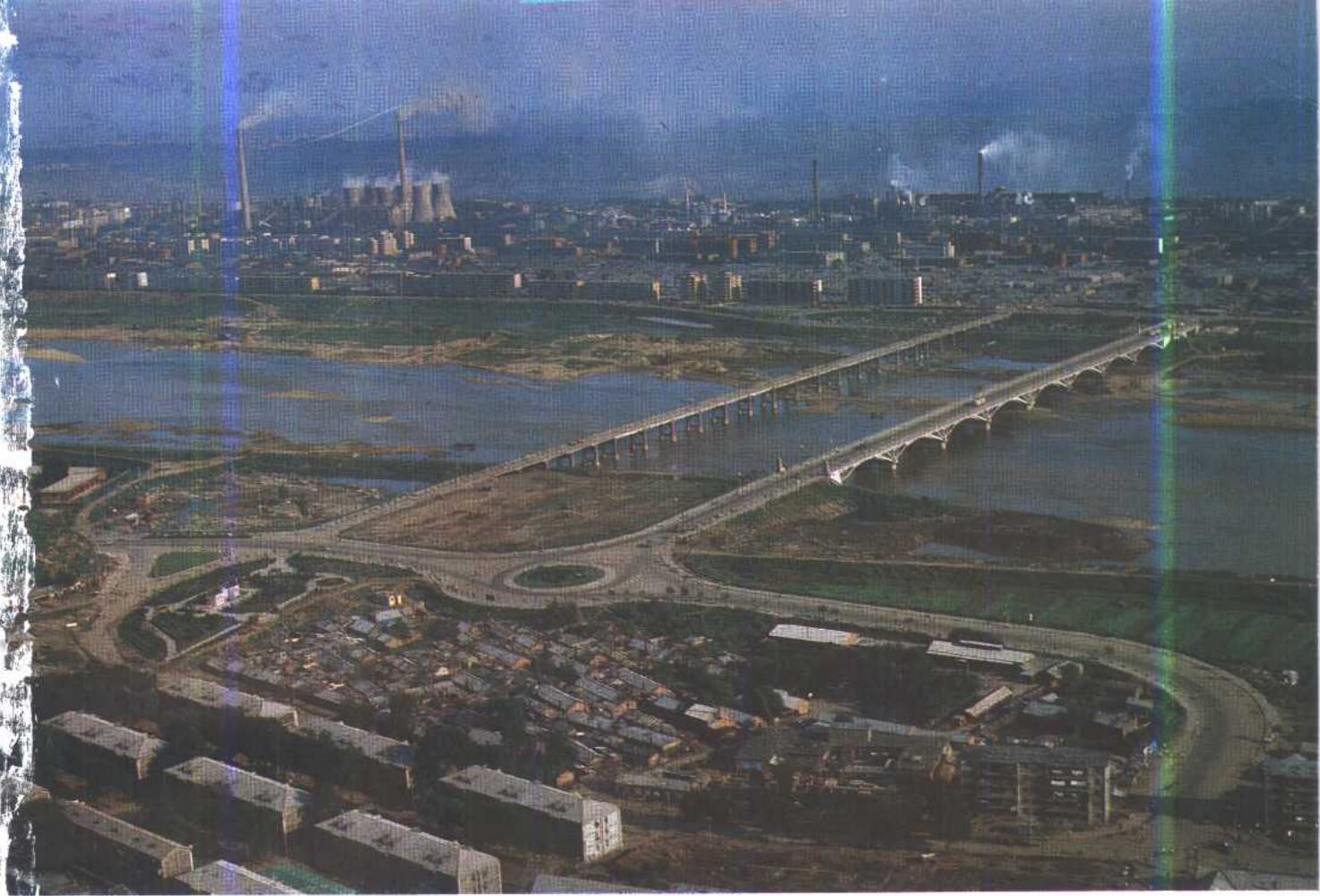
浑河戈布大桥 浑河南岸工业区
