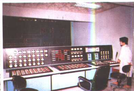
抚顺矿务局输煤系统应用可编程序控制器进行程序控制。图为程序控制室。
