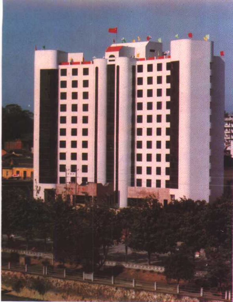
市人民政府大楼
