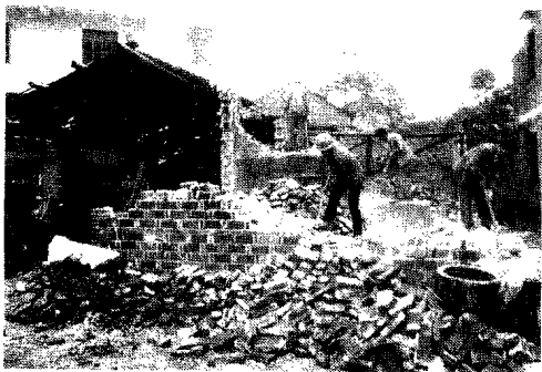
▲依法拆除违章建筑
