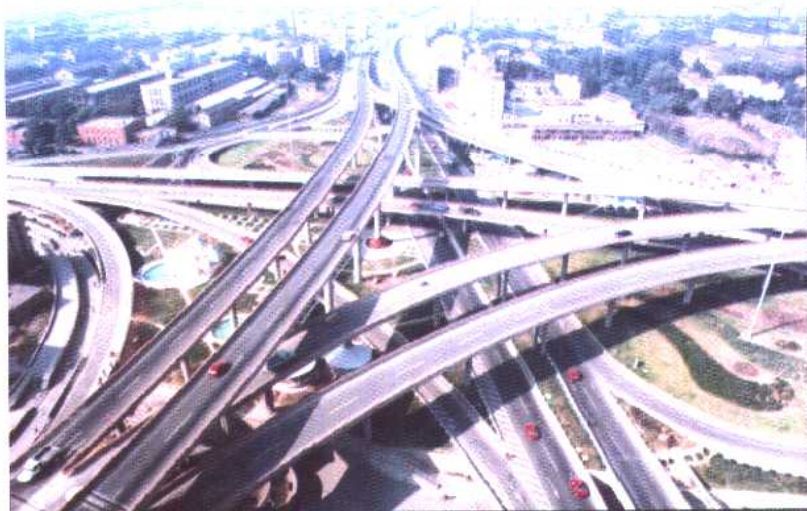
铁四局四处、二处施工的合肥 五里墩立交桥
