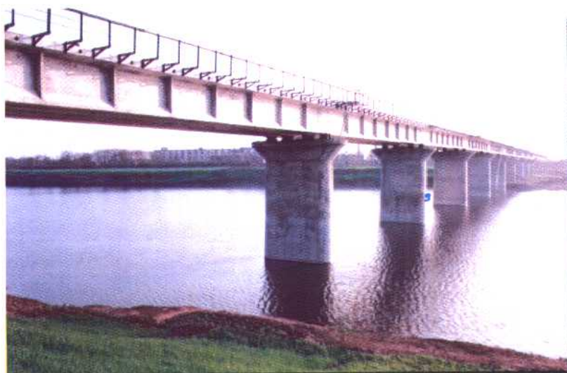
铁四局二处施工的京九铁路 阜阳枢纽颍河特大桥
