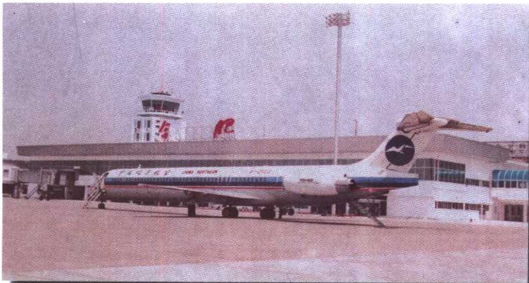
1997年改扩建后的合肥骆岗机场
