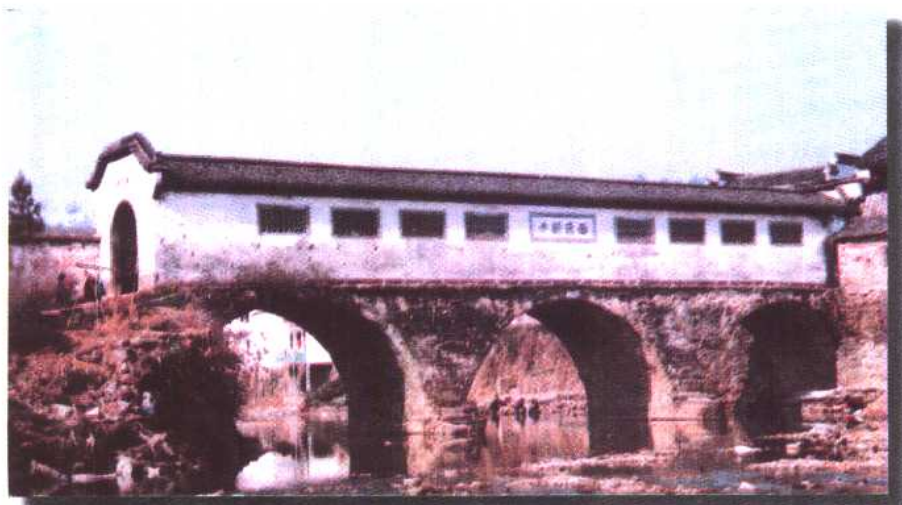
歙县北岸廊屋桥(明代)
