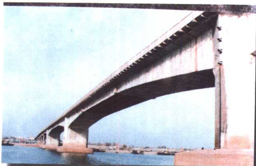
五河淮河公路大桥
