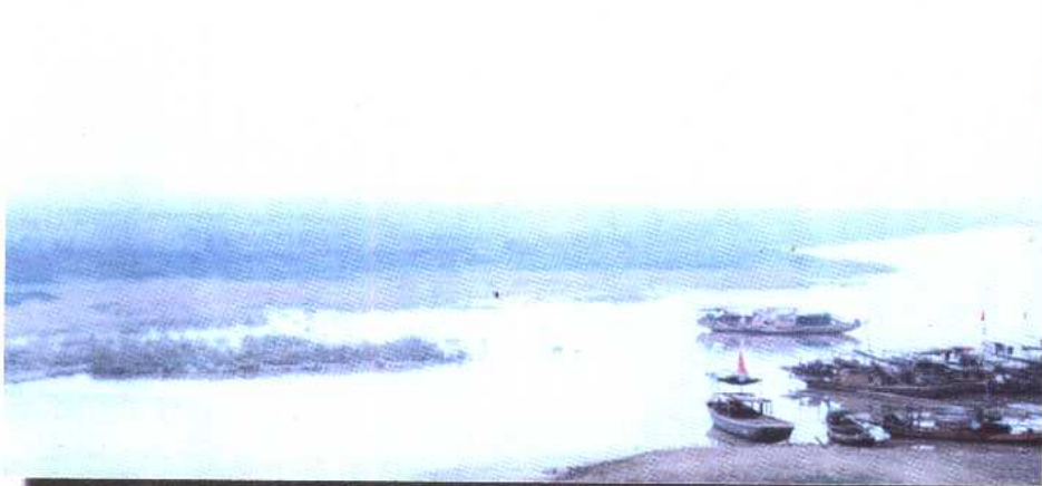
民国18年(1929年)10月21日安庆第一次通航的江边沙帽洲机场旧址
