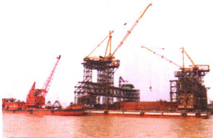
1997年正在施工中的芜湖长江 (公铁两用)大桥工地
