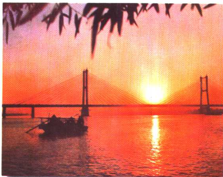
蚌埠淮河公路大桥
