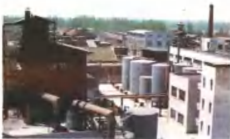
西洞庭造纸厂碱回收工程
