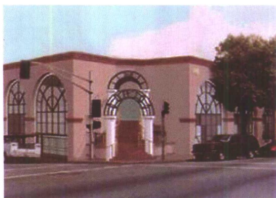
利用摄像机匹配创建外景
