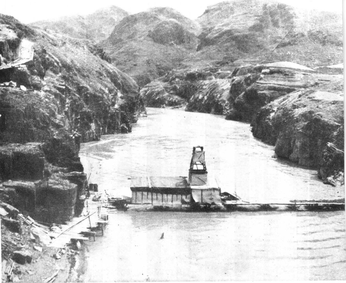
河面上架起了鑽探机，为攔河壩設計提供地質資料。
