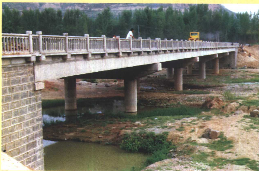
交口乡公路桥
