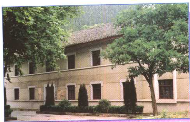
德江县人民政府办公楼
