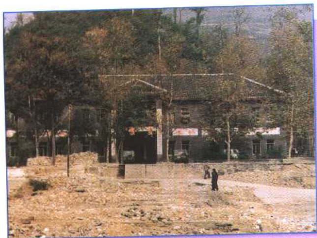
中共德江县委办公楼
