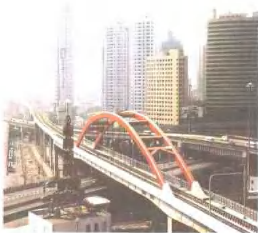
中国首条高架式城市轨道交通(电气化工程) ——上海明珠线
