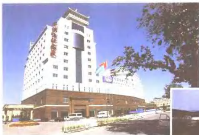
中铁工程大厦
