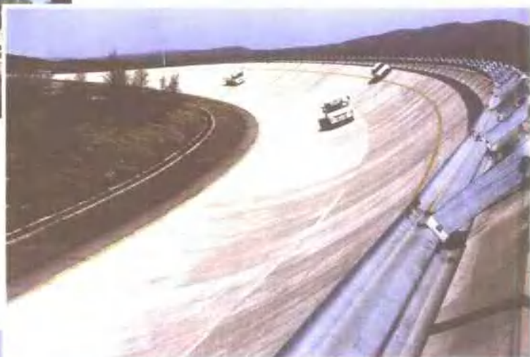
建成后的 高速环道
