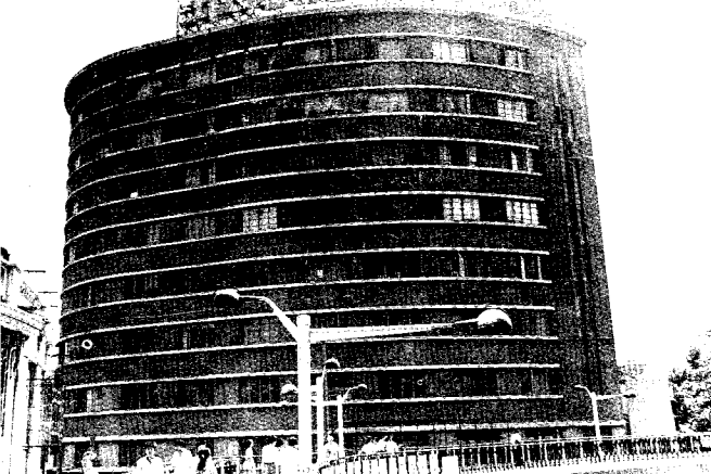
原中国银行上海分行同孚路办事处大楼 1933年建，位于今南京西路石门一路口
