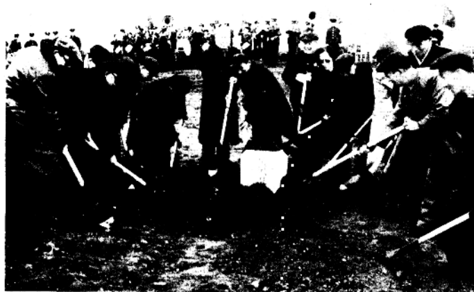
市党政领导参 加浑河治理工程破 土动工
