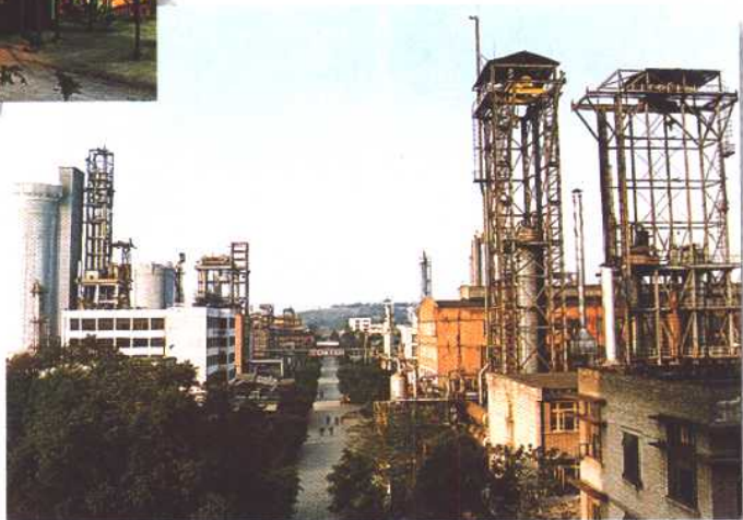
泸天化(集团)有限责任公司 10万吨合成氨+16万吨尿素装置 30万吨合成氨+48万吨尿素装置
