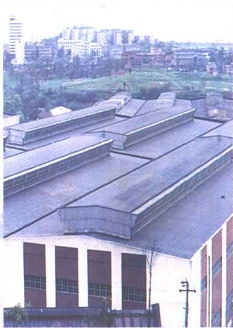
自贡东方锅炉厂蛇形管车间（80年代）
