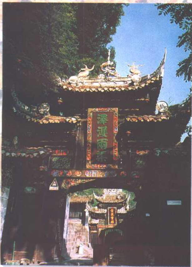
都江堰二王庙西牌坊（清代）
