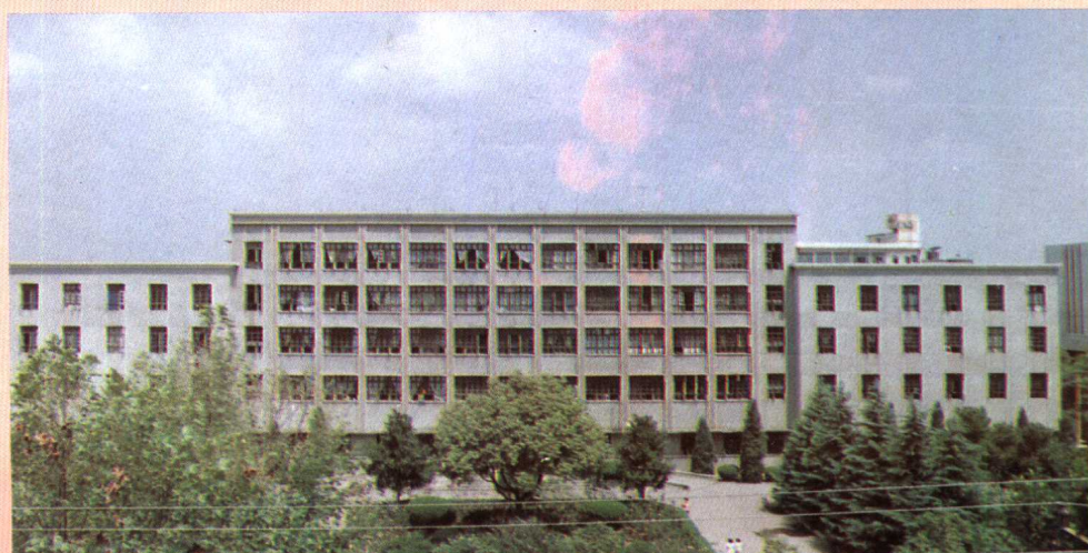
县人大、县政 府机关办公楼
