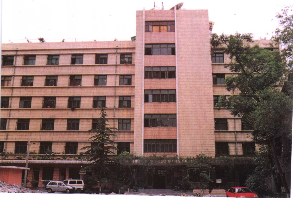
中共成都市西城区委办公大楼
