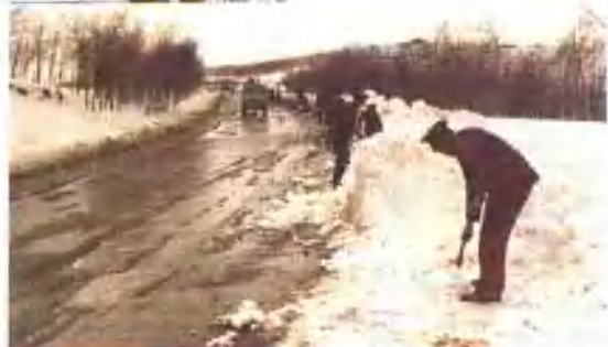
华家岭公路段段长王万山 和华家岭道班工人一起清除积 雪确保公路畅通
