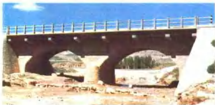
华双公路通渭陈家堡石拱桥
