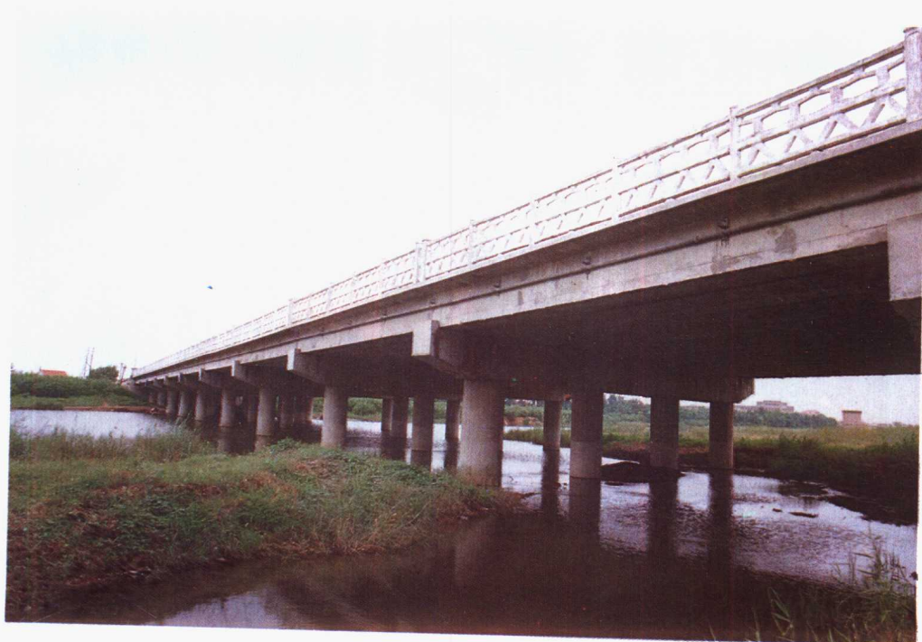
308国道上的白沙河流亭桥
