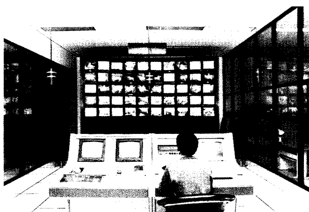
大连有线电视监控系统
