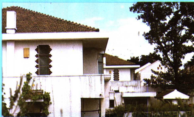
新建的后宰门住宅小区商品房 潘永椿 摄
