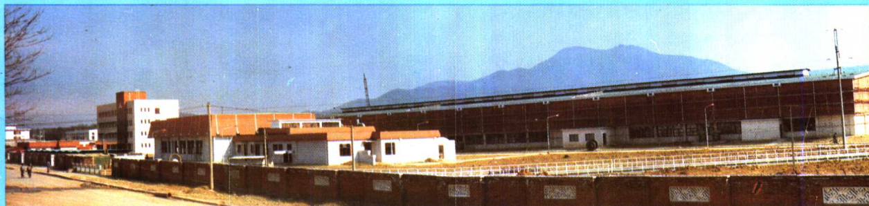
总公司承建的南京华飞彩色显像系统工程
