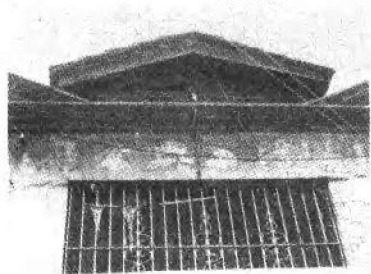
厦门华兴栈 (第一码头)
