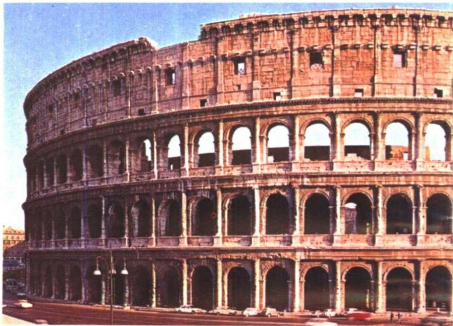
▲ 位于罗马的大圆形竞技场于公元80年建造，当时举行了一百天的人兽相斗的仪式。它是存留下来的古罗马圆形剧场当中最宏伟的建筑。这里看到的是用凝灰石筑成的建筑物正面，其上装饰着三种希腊“柱式”。多利安柱式在底层，上部是爱奥尼柱式和科林斯柱式。科林斯式半露柱位于顶部或顶层。在这里有用于支撑遮阳篷（天幕）的支柱以及悬垂着的盾形装饰物。
