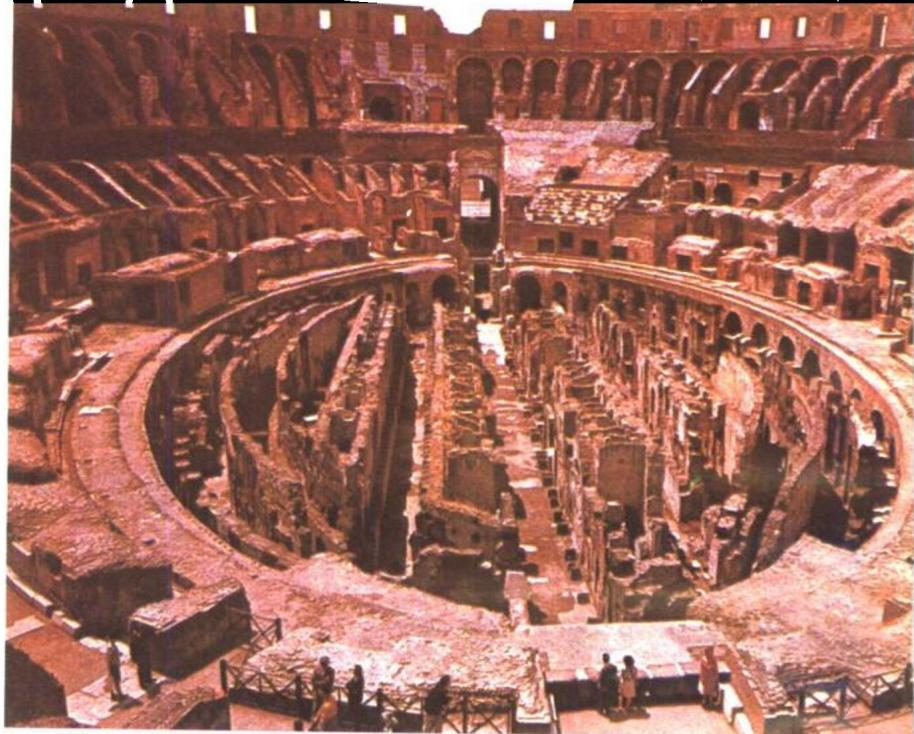
▲ 位于罗马城的弗莱文圆形剧场建于公元80年，俗称罗马大圆形演技场。它是古罗马建筑工程上的一大奇迹。剧场的地基、外墙和内部的窗间壁都是凝灰石的，屋顶内部是用水泥构筑的；供较有声望的人使用的较低的座位都是大理石的，而上部的座位却是木制的。同心走廊支撑着层层排列的连着阶梯的座位。这个演技场可供45000名观众使用。贮藏室隐藏在椭圆形的表演场之中。
