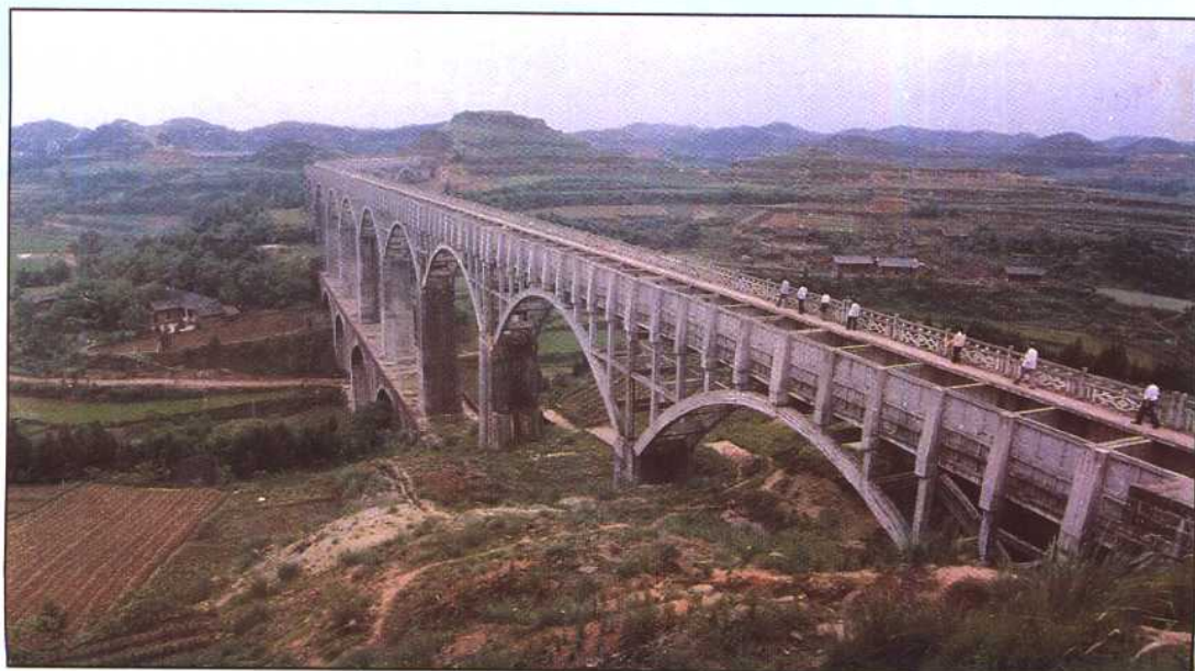
中江县引都江堰水跨郫江上源的双林渡槽
