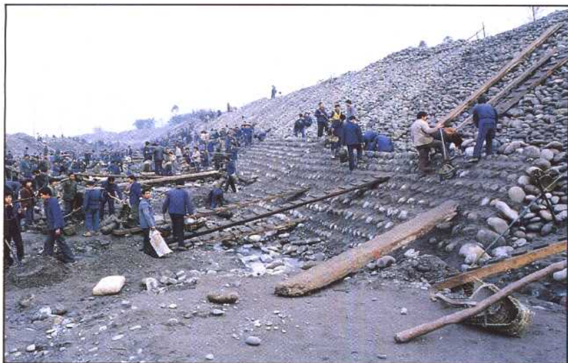
岷江金马河新津段 岁修浆砌卵石护岸防洪大堤
