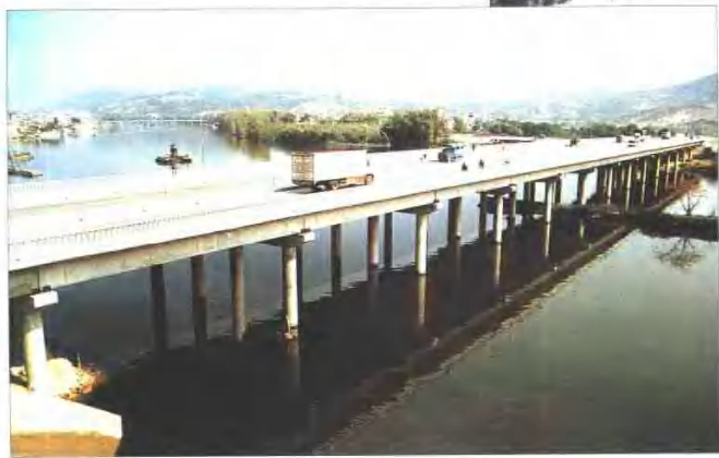
漳江鲤鱼洲大桥
