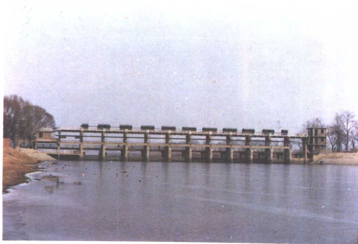
徒骇河刘桥节制闸
