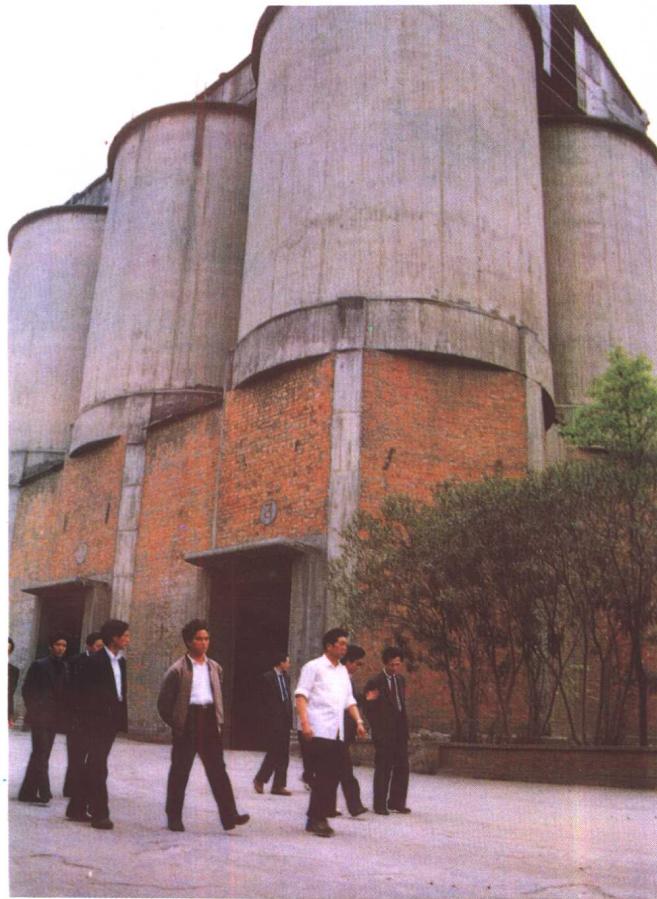
位于成都市龙潭寺 的成都市建筑材料公司 的可储装一万吨水泥的 西南地区最大散装水泥 库
