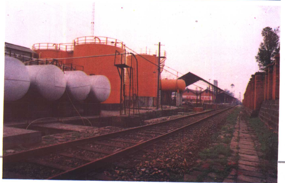
位于成都市龙潭寺的 成都市化轻公司可储存多 种化工产品的化工仓库一 角
