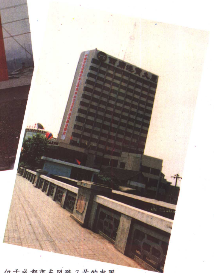
位于成都市东风路7号的中国汽车贸易总公司西南公司办公与经营大楼
