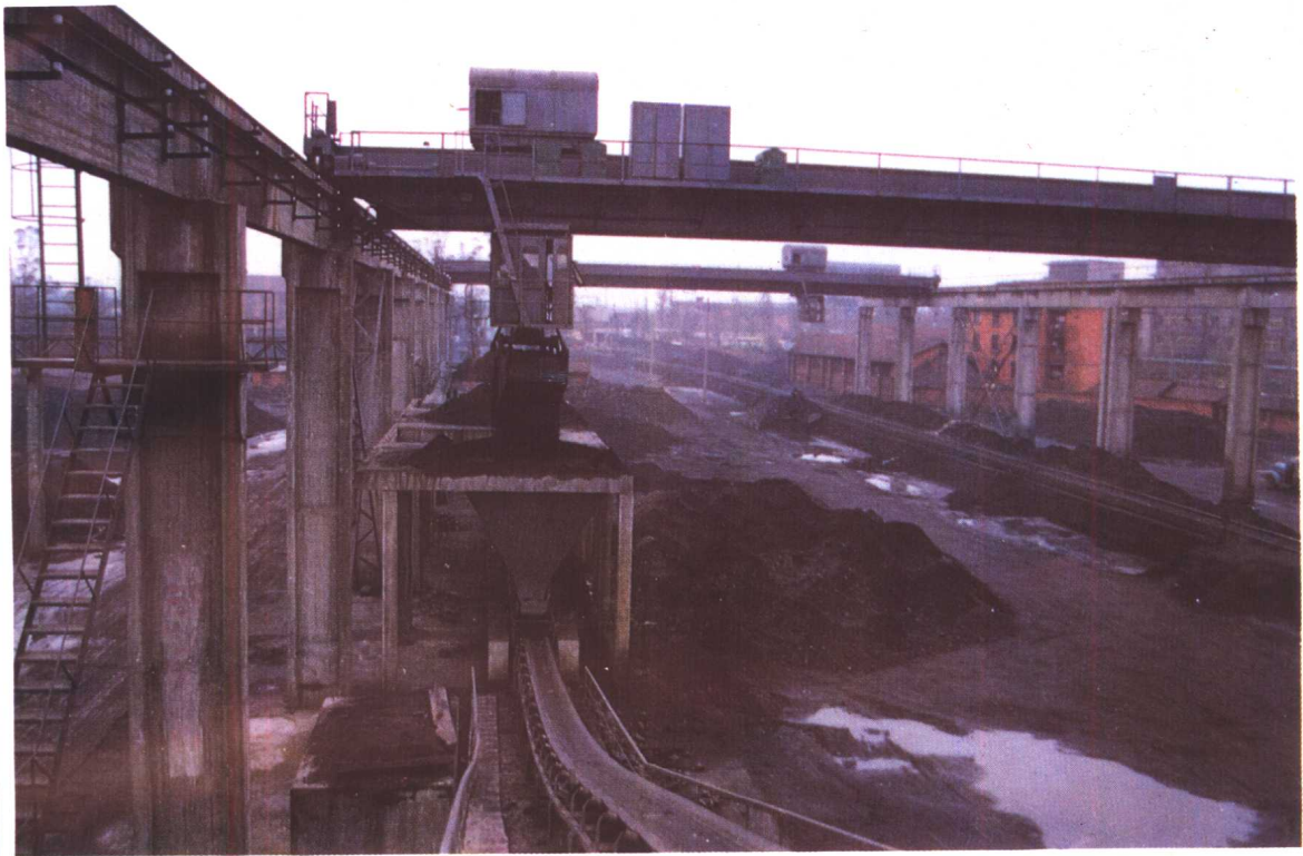
位于成都市府青路2号 的成都市燃料公司机械化动 力配煤线
