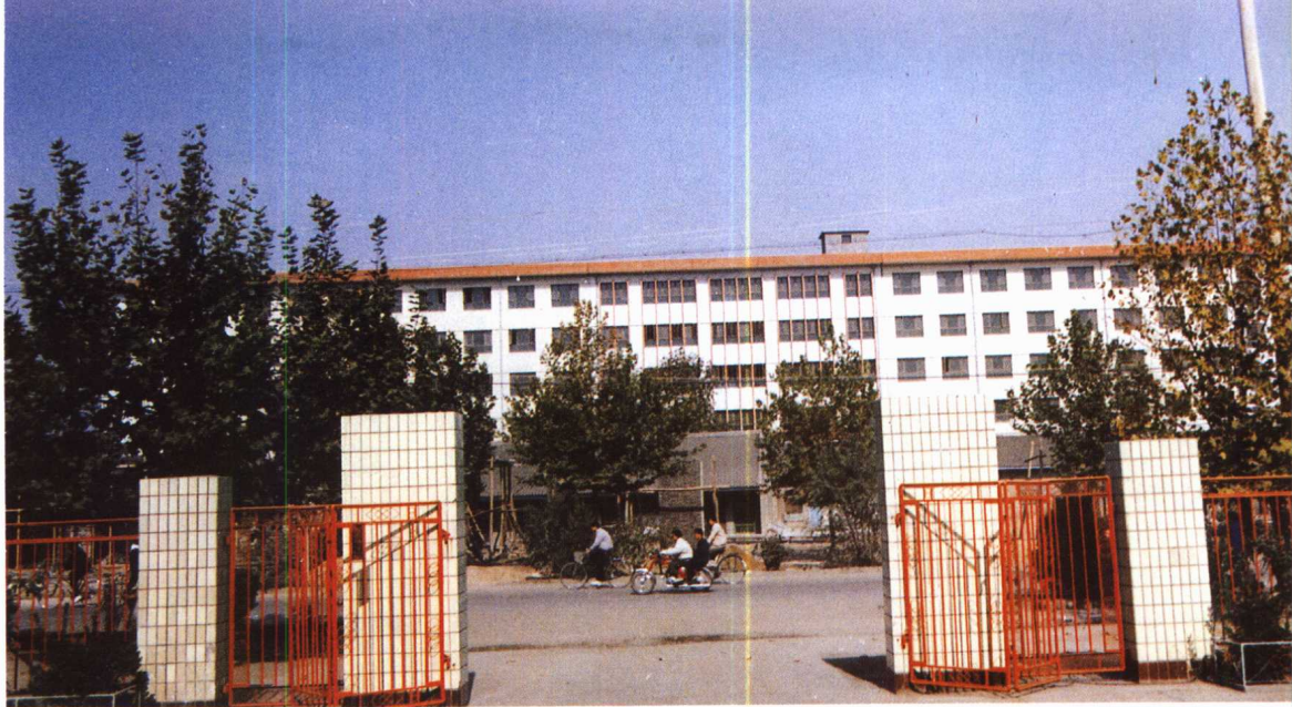
政府办公大楼▶
