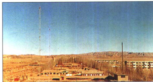
位于巴丹吉林沙漠和腾格里沙漠交汇处的雅布赖国际导航台
