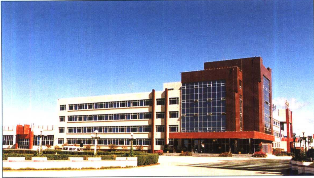
民航内蒙古区局办公楼
