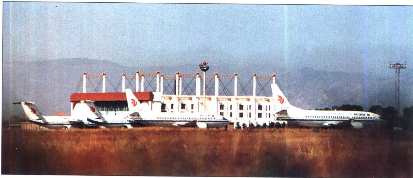
同时检修波音-737、BAe-146型客机各一架的机库
