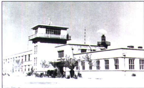
呼和浩特白塔机场第二代候机楼(1959年建)
