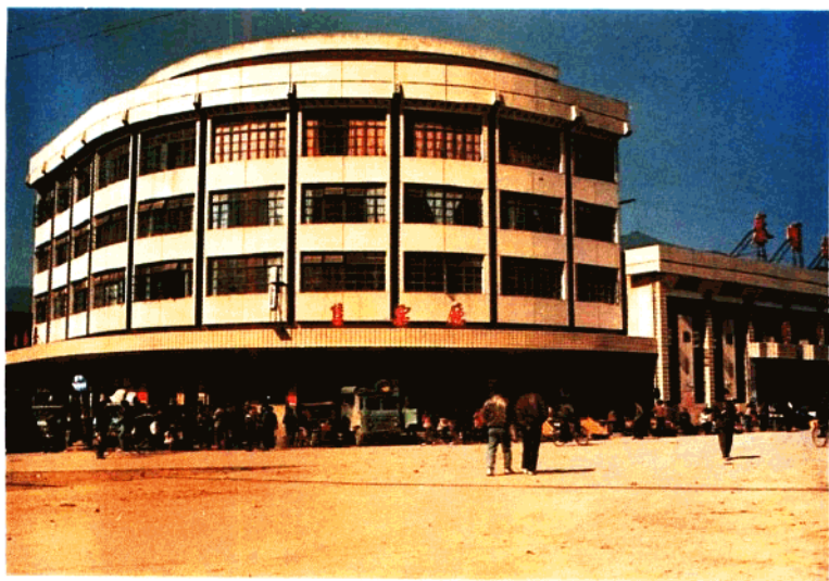
泰顺县汽车站
