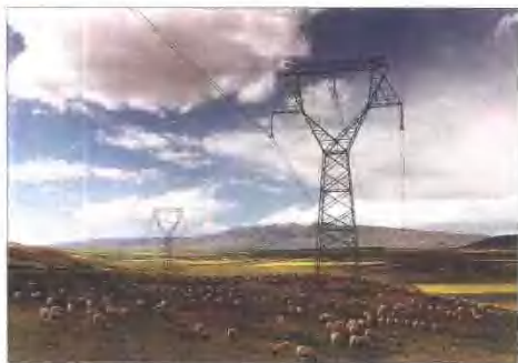
高压输电线路
