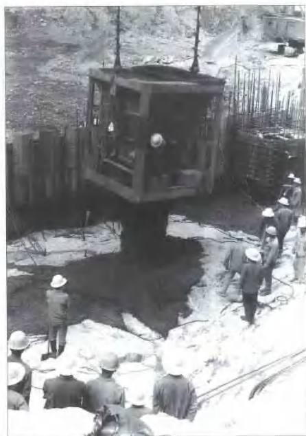
1982年6月28日，大坝第一罐混凝土开盘浇筑
