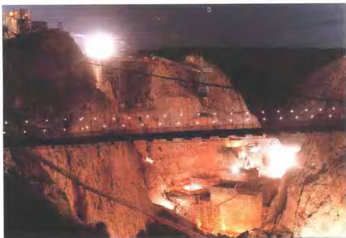
主坝初期施工夜景
