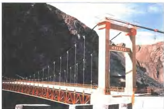
龙羊峡黄河大桥
