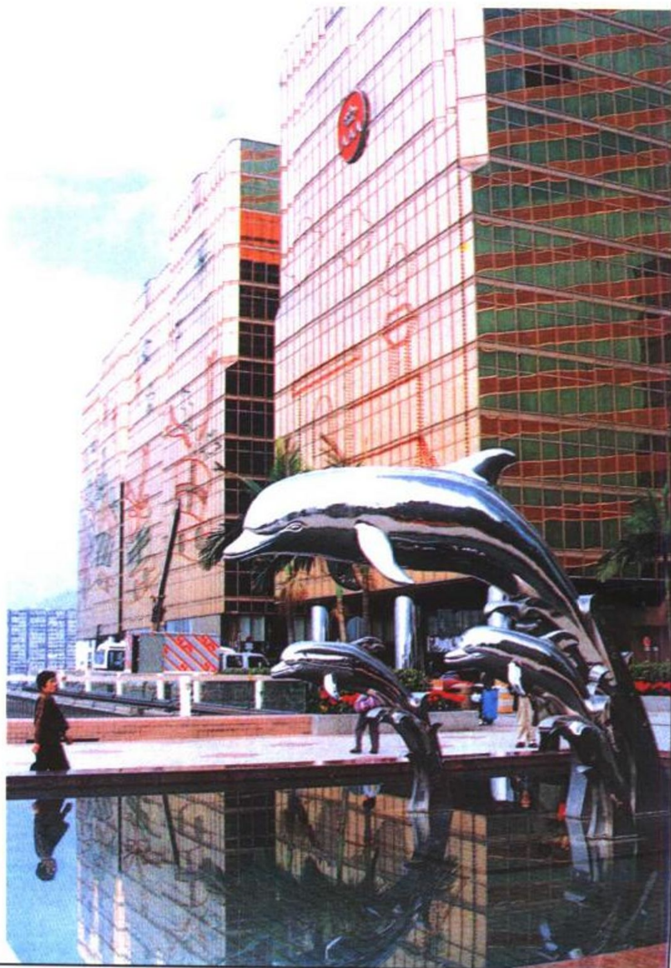
香港中港城平台上的开敞广场
