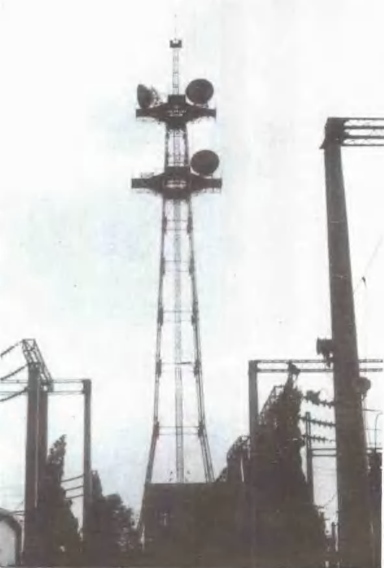
76 米微波通讯塔
