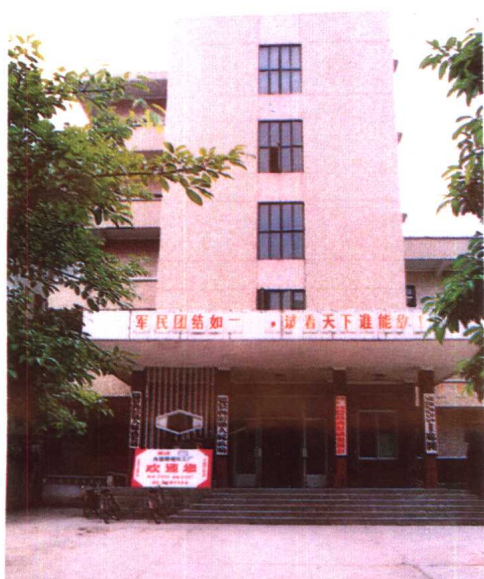
西彭镇人民政府办公楼
