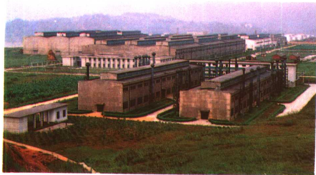
建设中的重庆大江车辆总厂厂房建筑群
