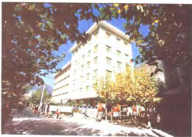
县委、人大、政协办公大楼
