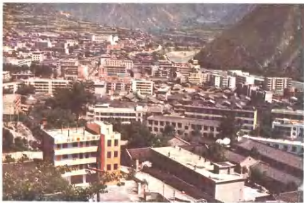
建设中的县城一角
