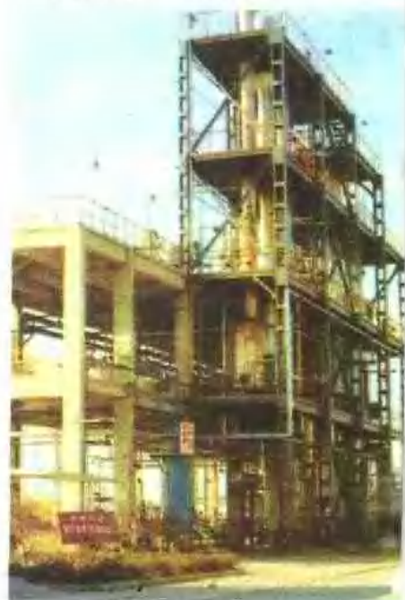
泰州石油化工厂甲基叔丁基醚和甲乙酮装置
