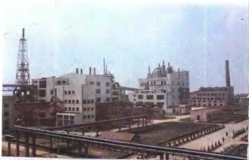
铜陵磷铵厂引进 12 万吨磷 铵 / 年复合配料装置
