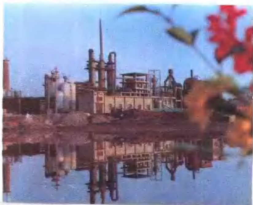
风台磷矿硫酸车间外景
