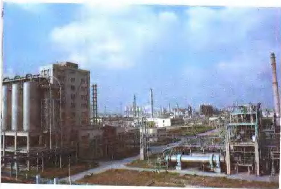
南京扬子石油化工 公司乙烯工程
