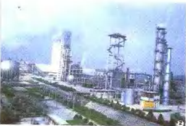
安庆石化总厂引进 30 万吨合成 氨 / 年大化肥装置
