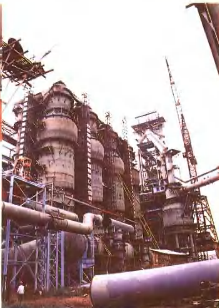
►中国人民建设银行安徽省分行加大对马钢的投入,图为正在建设中的马钢 2500m 3 高炉主体。
