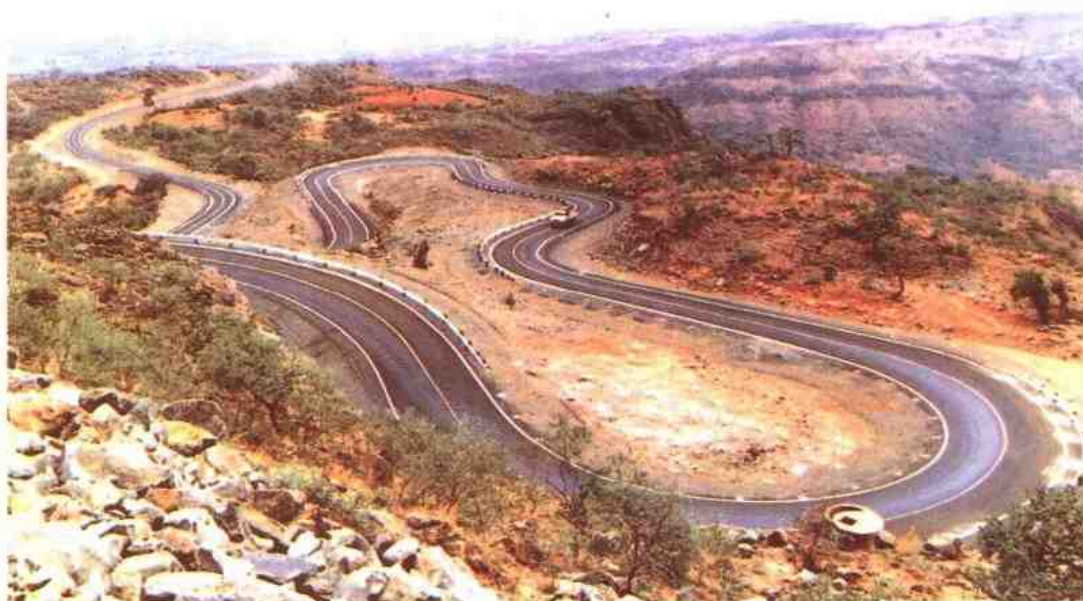
▲中信实业银行 1992 年贷款支持中国公路桥梁建设总公司承建的项目——肯尼亚卡次公路。
