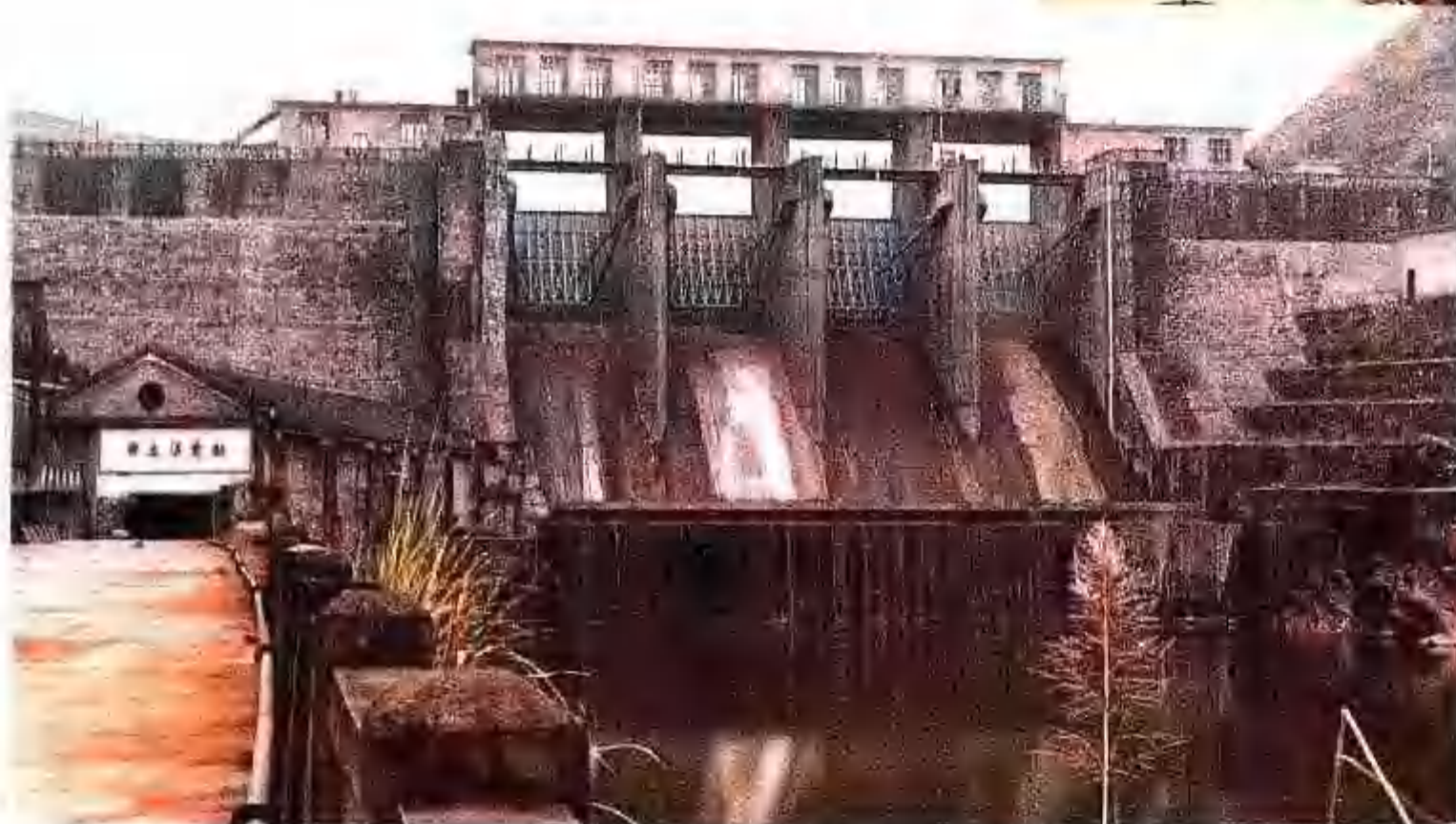
◀ 黄土溪水库电站大坝
