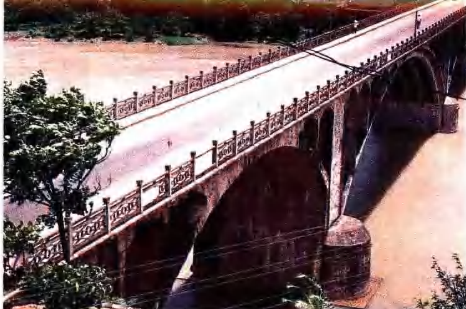
◀ 奎田溪公路桥
