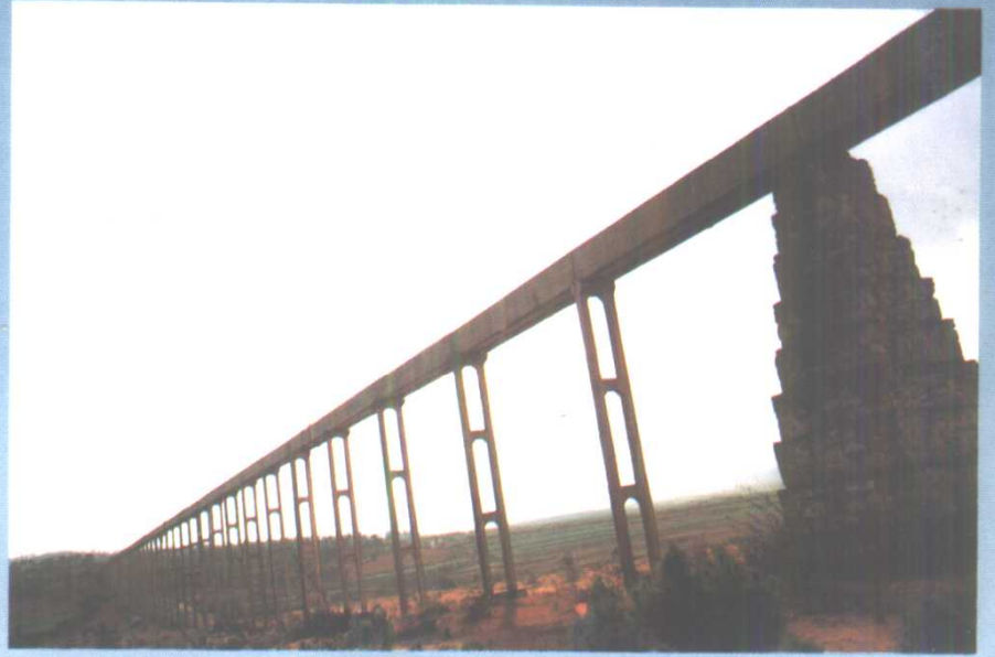
引水渡槽 (董石玉 摄)
