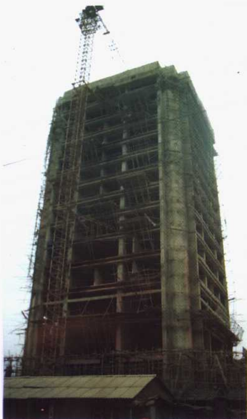
建设中的毕节地区商业贸易中心
