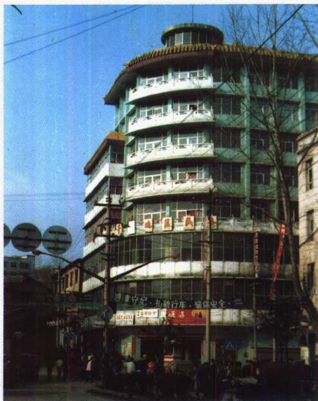
毕节地区民贸公司大楼
