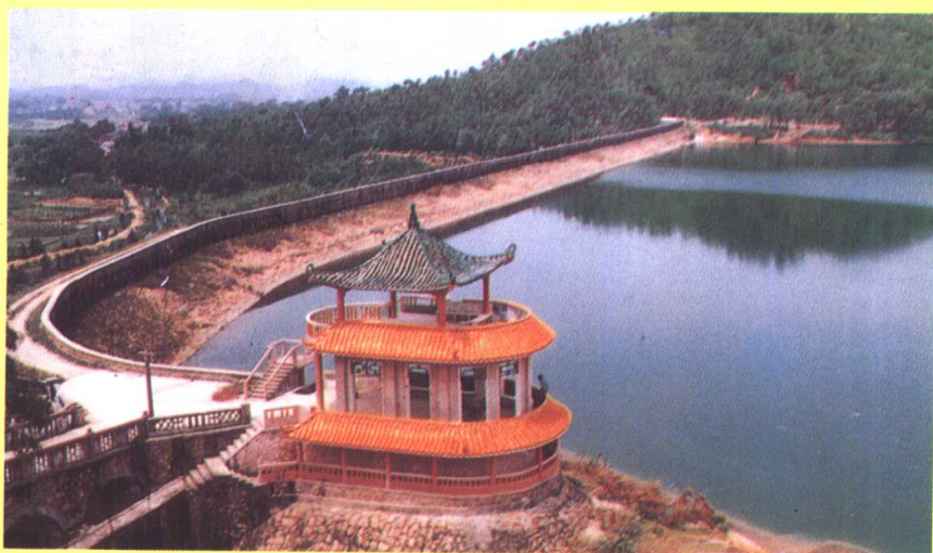
芙蓉峰水库主坝
