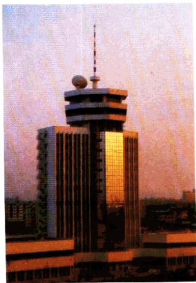
4. 武汉市广播电视大楼
