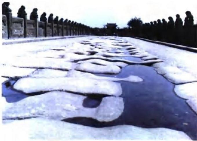
卢沟桥全长266.5米、宽7.5米，桥身涵洞共计11孔。整个桥体都是石结构，关键部位均有银锭铁榫连接。特别是桥墩造法颇有特色，墩平面呈船形，迎水面砌作分水尖，外形像一个尖尖的船头，其作用为抗击流水的冲击。桥上的石刻十分精美。望柱、栏板上的
