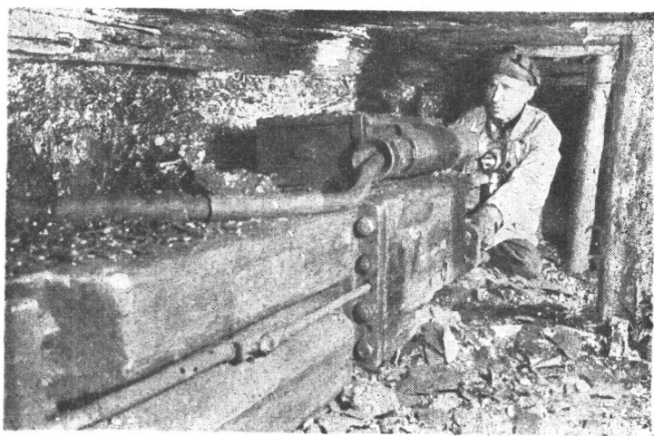
頓巴斯大林州基西列夫煤礦先進礦工安德里因科在掌子中 使用〔頓巴斯〕式聯合採煤機。
