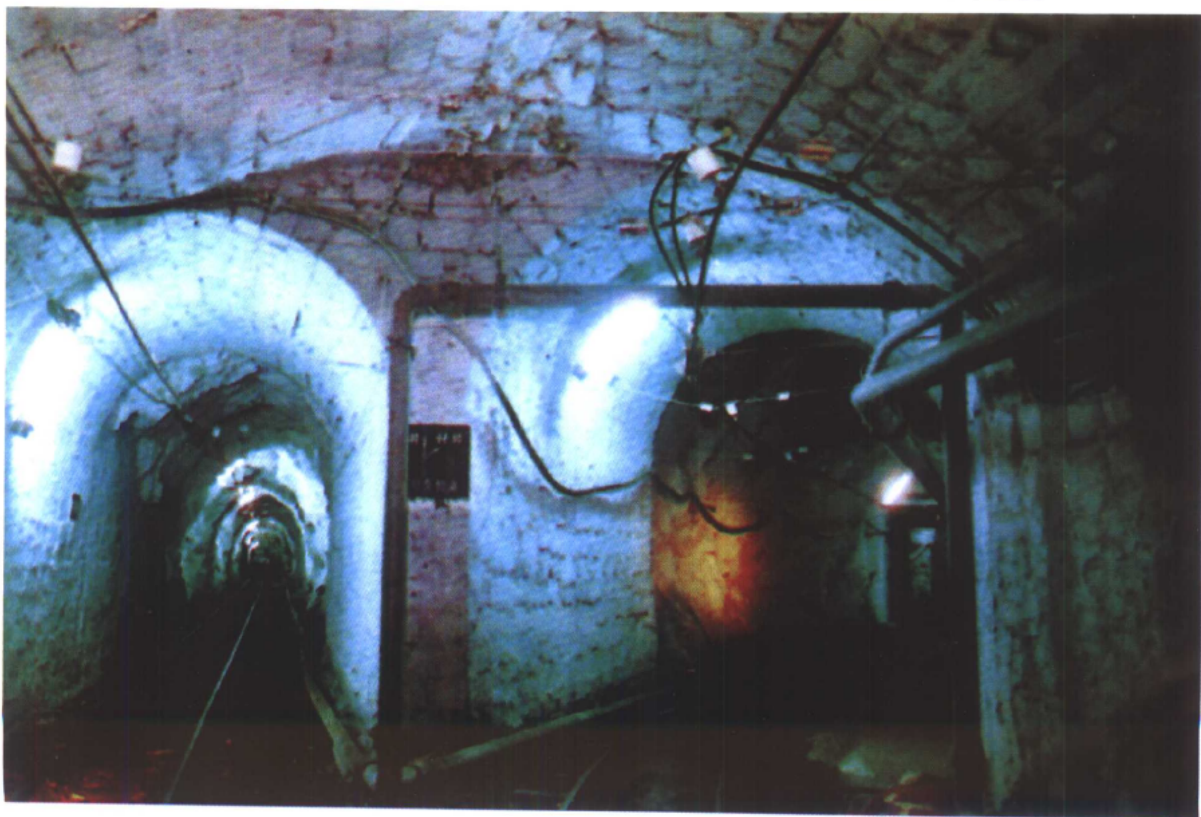
煤矿井下交岔点
