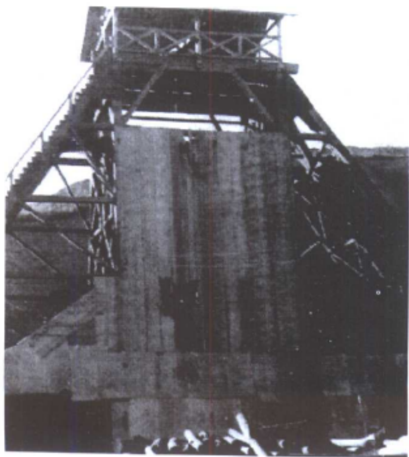
建设中的曲仁煤矿云顶立井 (1958年)
