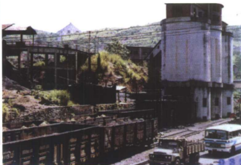
煤矿圆筒煤仓
