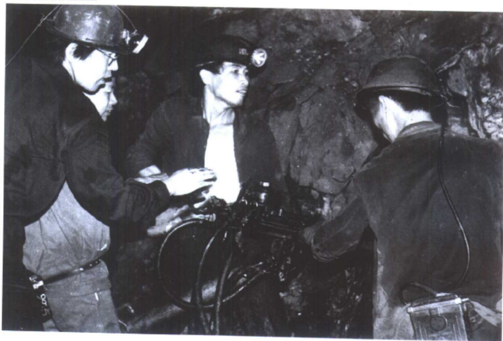
手持式液压凿岩机在四望嶂矿务局井下作工业性试验
