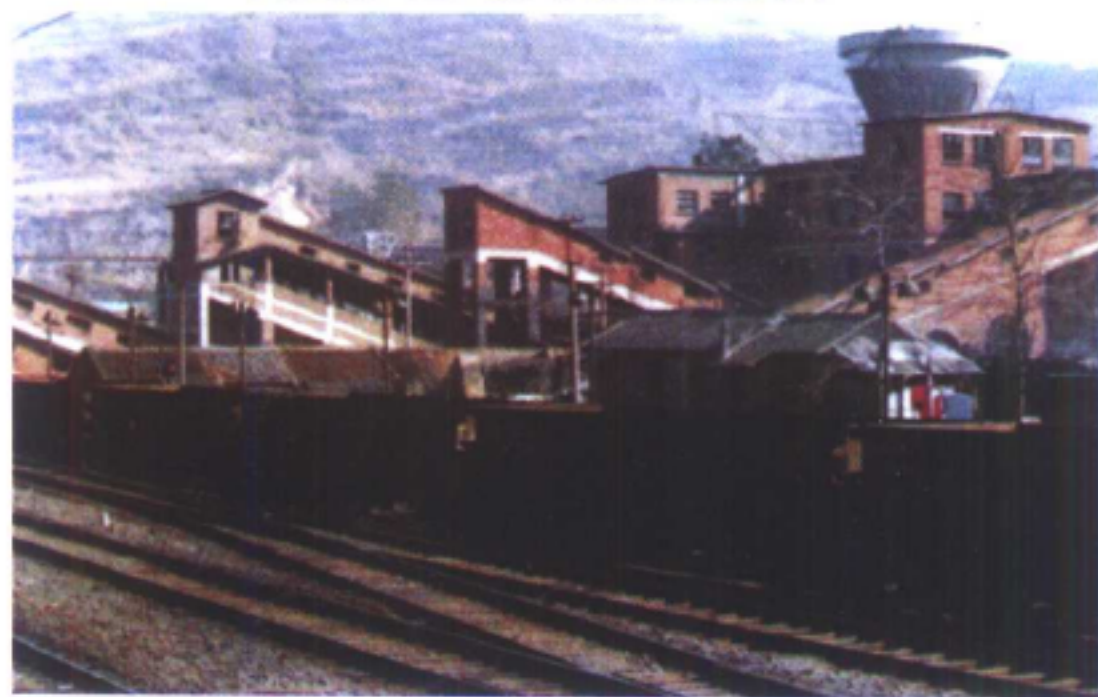
南岭煤矿坪石洗煤厂
