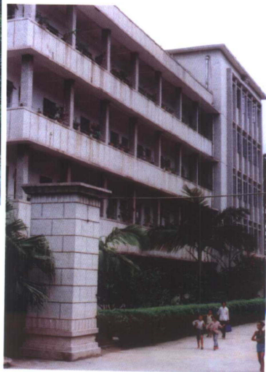
茂名矿务局办公楼
