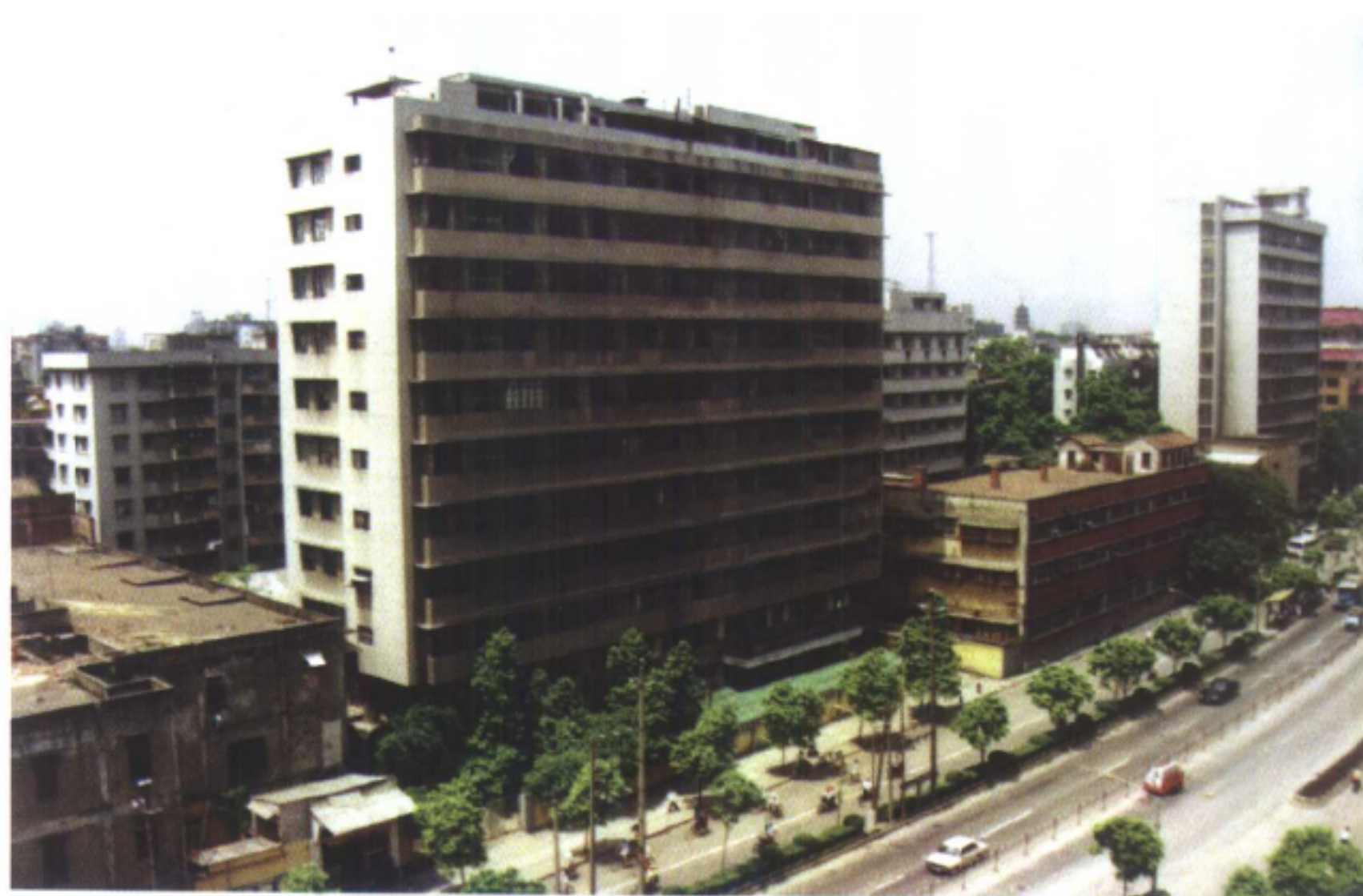
广东省煤炭工业总公司办公楼
