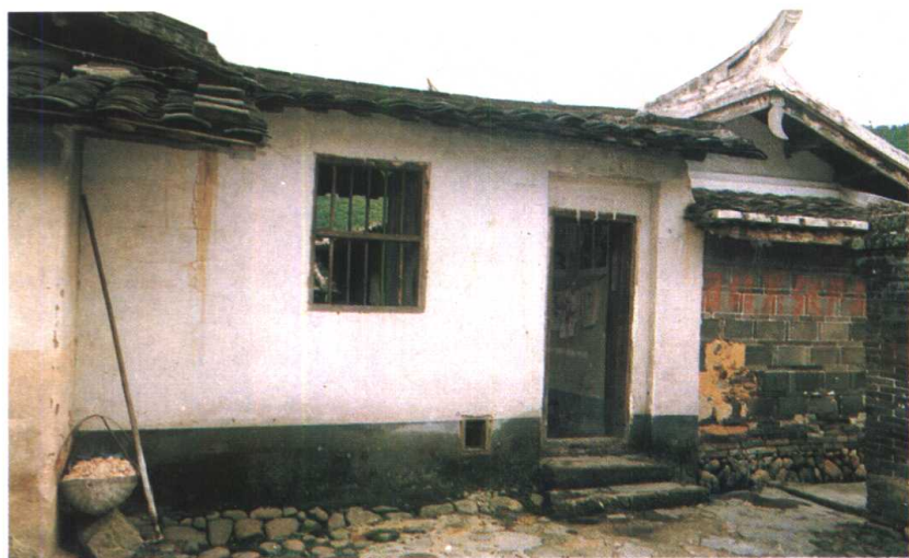
解放前養路隊工 人的住房——龍 岩石牌前林家祠 堂（原厦隘綫）
