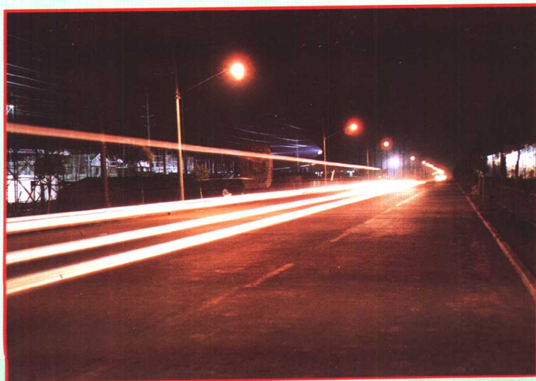
4. 川北公路县城至张江段沿线安装好路灯 (王海连摄)
