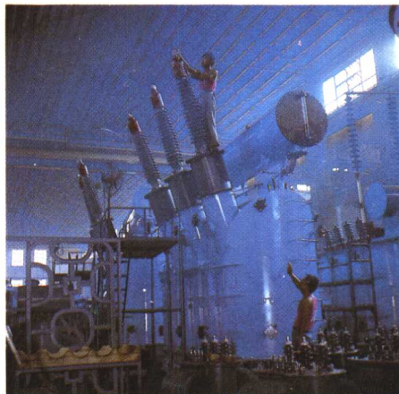
▲ 由三台机床、30名工人、300元资金起家的常州变压器厂，现已发展成为华东地区规模最大的变压器制造厂。
