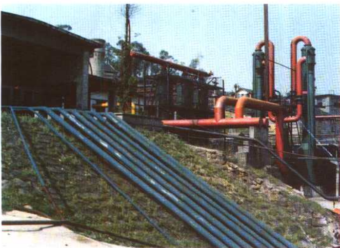
邓关盐厂脱硫车间
